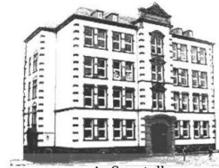
Außenstelle Assenheimer Str. 38-40 (Grundschule)
