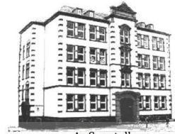
Außenstelle Assenheimer Str. 38-40 (Grundschule)
